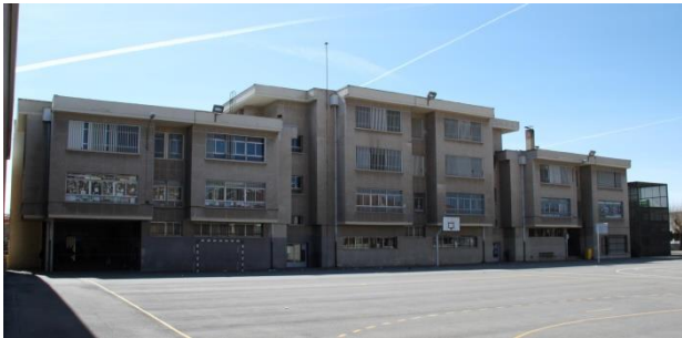
Edificio de Primaria
